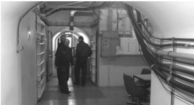
Hodnik in instalacije v podzemnem atomskem zaklonišču GŠ JLA (Google, Slike)
