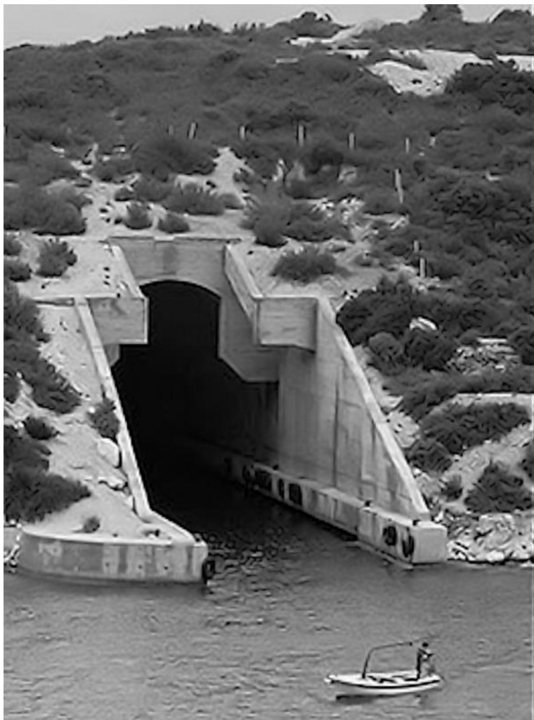
Zaklonišče za podmornice, Vis, 1992 (Google. Slike)
